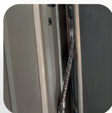
cable gland (optional accessory) Przepust kablowy (akcesorium opcjonalne)
